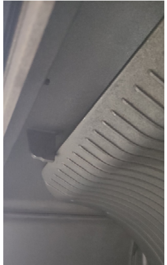
Défecteur en appui sur les pattes de maintien
